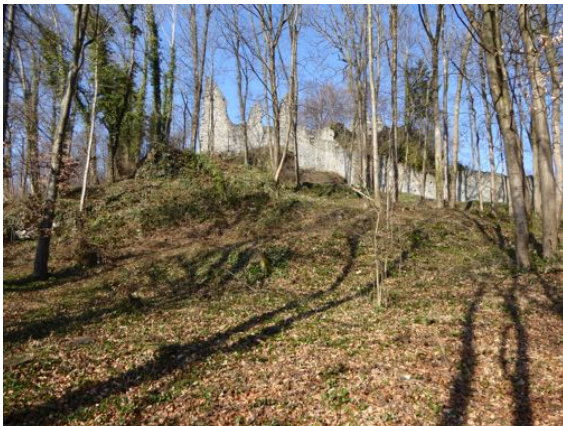
Abb. D1/D2: Sicht auf Hauptburg von Fußweg aus
