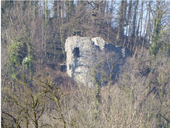
Abb. C1: Sicht von Südost von der Nähe
